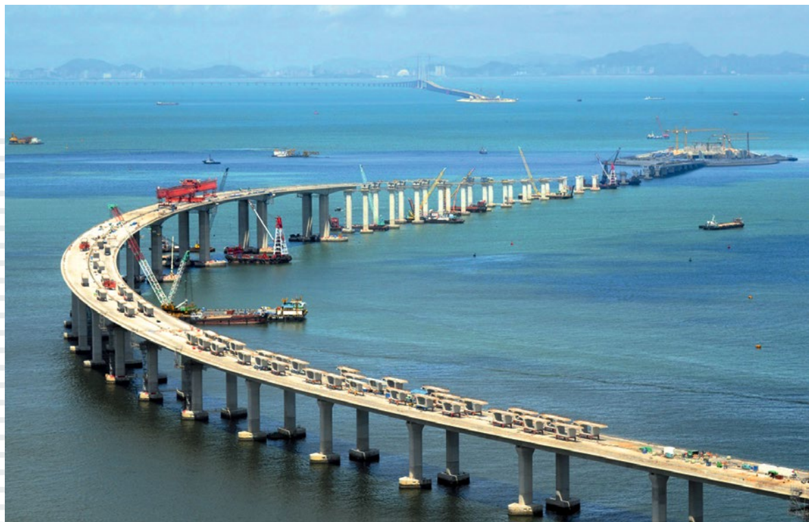
正在建造的港珠澳大橋香港接線。
