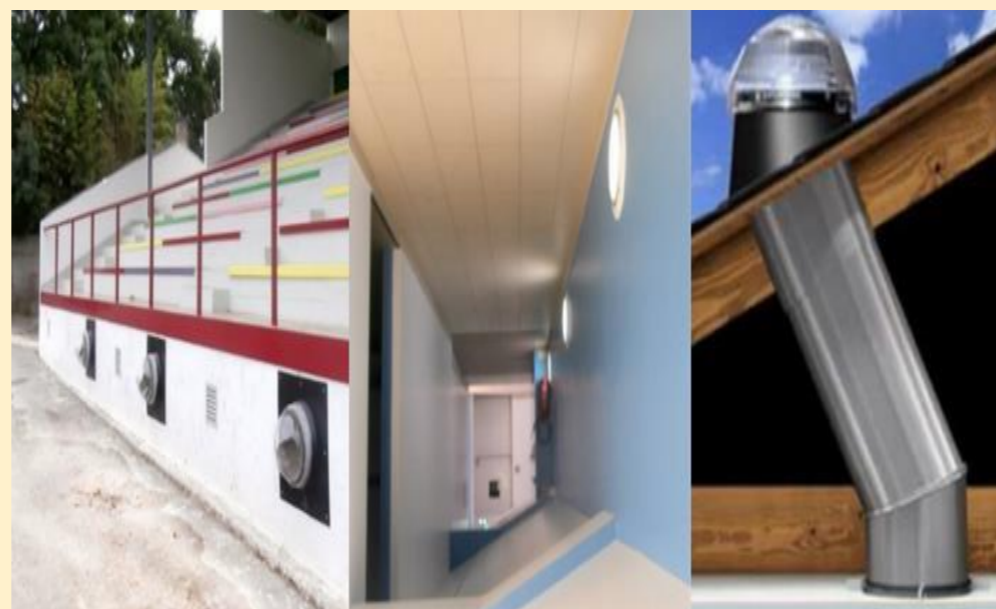
圖15：使用太陽光導管和太陽能板
